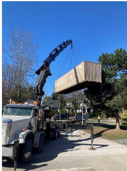
图3 花园项目的第一步是将 40 英尺的海运集装箱从花园场地移走，并搬迁到礼堂外，用作戏剧部的长期储存容器。
